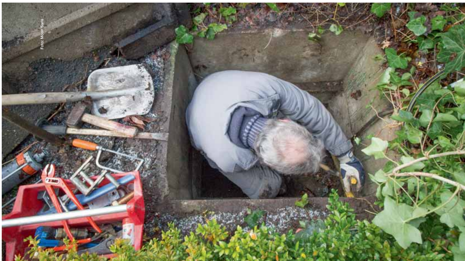
Een oudere monteur heeft bergen ervaring en kan zijn kennis overbrengen op jonge collega's.
